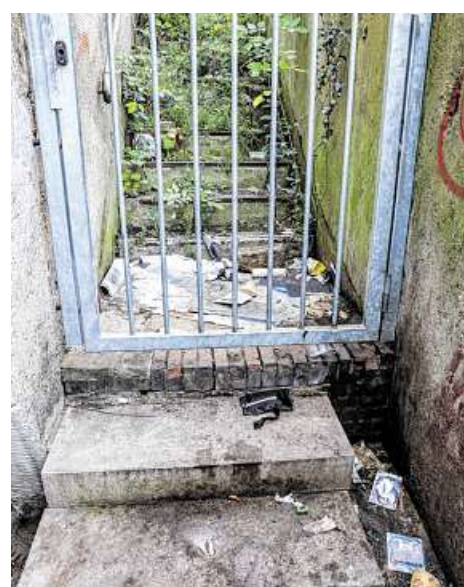
Rund um den Gustav-Deetjen-Tunnel sammelt sich der Müll.
