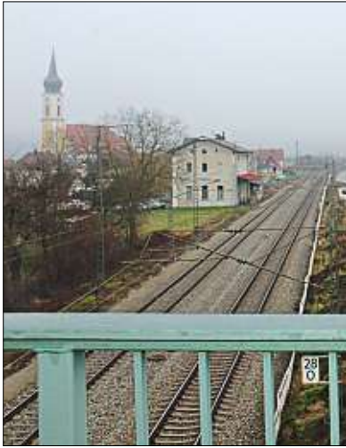
Das Geländer hat die grüne Farbe der drei Meter hohen Lärmschutzwand, die die Deutsche Bahn in Pleinting bauen will.
