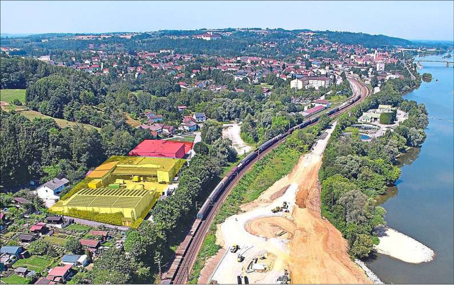
Zwischen der Kleingartenanlage und der rot markierten Gemeinschaftsunterkunft für Asylbewerber befindet sich am Galgenberg vor den Toren der Stadt ein kleines Gewerbegebiet (gelb markiert). Investoren möchten die Flächen erwerben und dort Wohnungen errichten. Das Luftbild entstand im Sommer, als der Kreisverkehr für die B 8 noch im Bau war.
