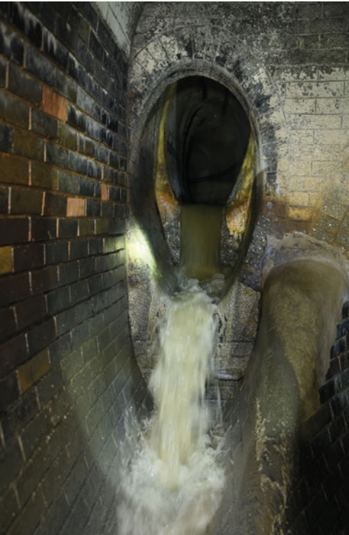
Zusammenfluss: Ein Schwall Abwasser donnert neben uns in den Kanal.
