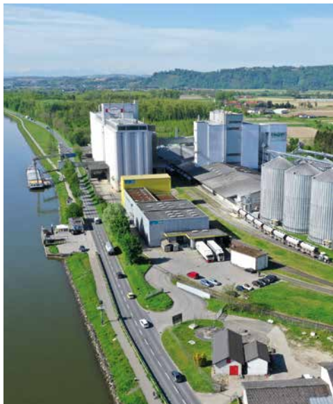
△ Hightech-Betrieb: die modernisierte Rapso-Ölmühle in Aschach.
