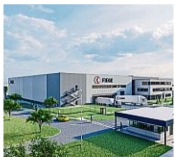
Das Logistikzentrum befindet sich im Bau. Illustration: Fiege
