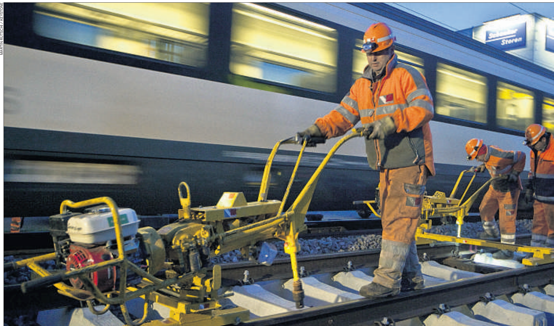
Erneuerung von Schotter, Schwellen und Schienen. Gleismonteure arbeiten Nacht für Nacht; dennoch gelingt es nicht, das Trassée à jour zu halten. (Aarau-Schönenwerd, 2010)
