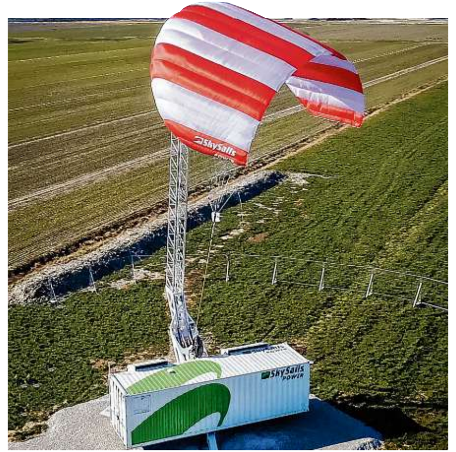
Stephan Wrages Flugwindkraftanlage auf einer Wiese in Schleswig-Holstein: Während der Drachen in zwei Minuten auf bis zu 400 Meter Höhe aufsteigt, zieht er ein Kunststoffseil von der Winde ab und treibt so einen Generator an. BILD: SKYSAILS
