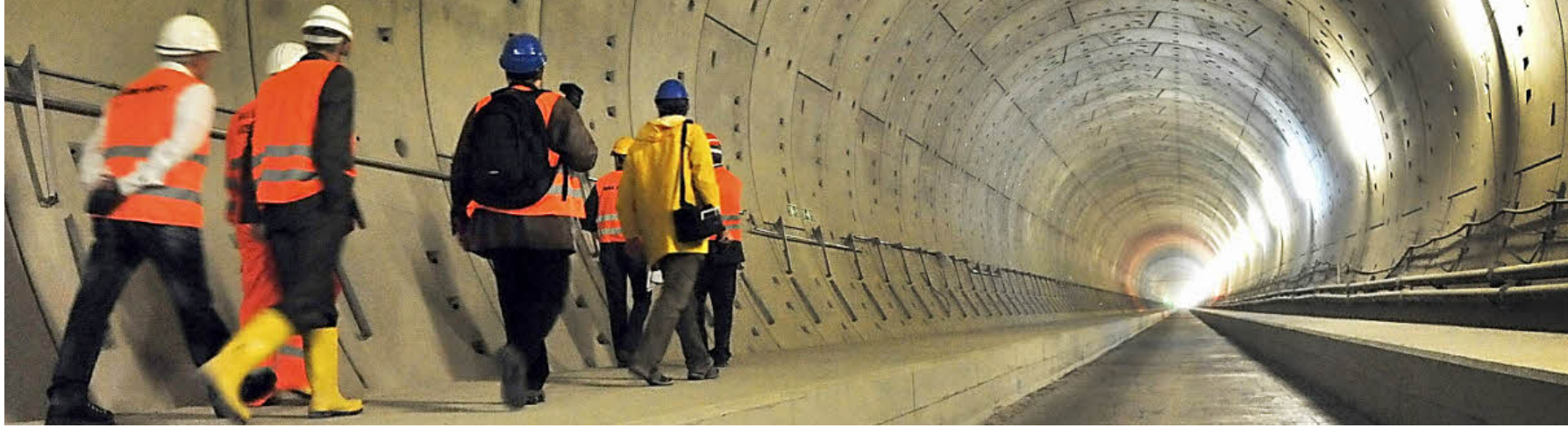
Teilnehmer einer Presseführung gehen bei Efringen-Kirchen (Kreis Lörrach) durch den im Rohbau fertiggestellten Katzenbergtunnel. Mit einer Länge von 9385 m wird er der drittlängste Tunnel Deutschlands sein.
