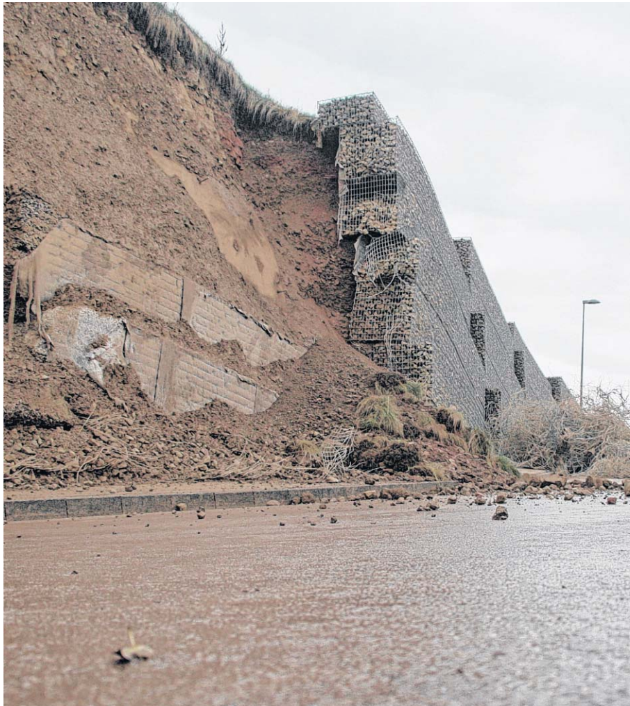
Nach dem Einsturz (links) und nach der Instandsetzung: Steine der Gabionenmauer liegen im Oktober 2012 auf der Verbindung 134 (Bahnhofstraße). Inzwischen ist der Zaun repariert.
