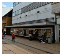
5) Königstraße 29: Das „Telekom“-Haus
