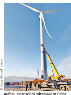
Aufbau einer Windkraftanlage in China
