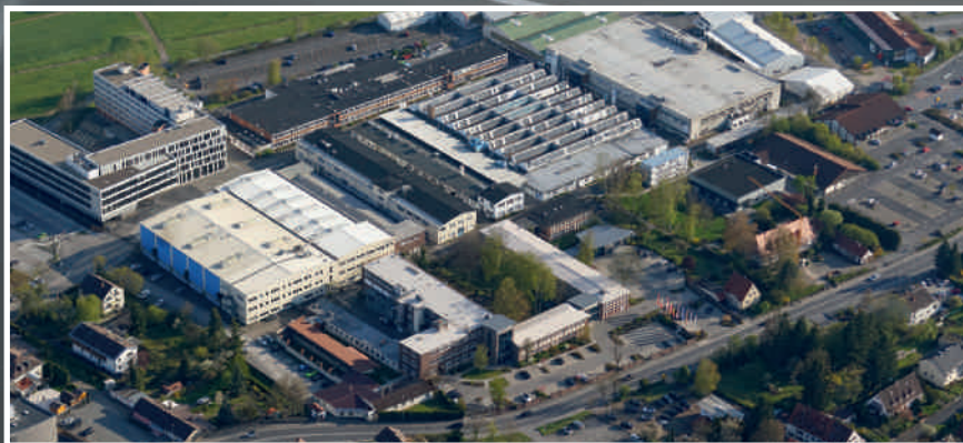
Blick auf den Hauptsitz von Preh in Bad Neustadt an der Saale mit aktuell zirka 1700 Beschäftigten.
