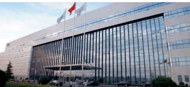
Firmensitz, Verwaltung und das zentrale Technologiezentrum der Beijing Oriental Electronics in Beijing
