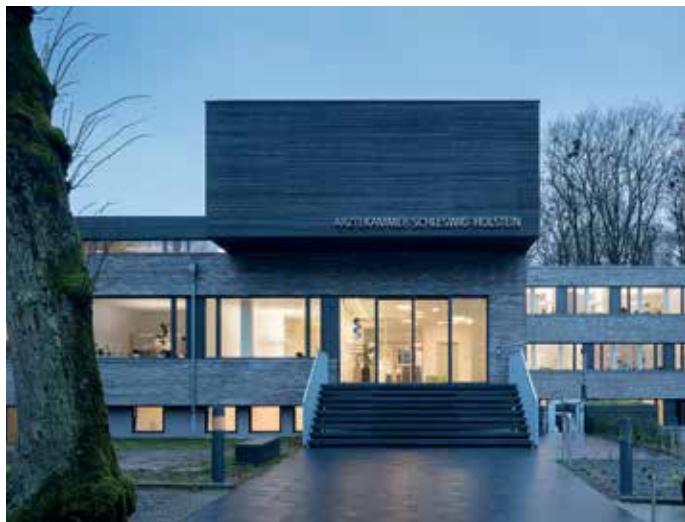
Abb.: Die Fassade der sanierten Betonskelettbauten zeigt sich heute in einem hellgrauen dänischen Ziegel im Langformat. Aufgrund der soliden Bausubstanz und zeitlosen Optik entschlossen sich Bauherr und Architekten für eine Sanierung statt Abriss und Neubau.
