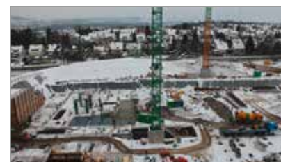
Januar 2013 Winter auf der Baustelle
