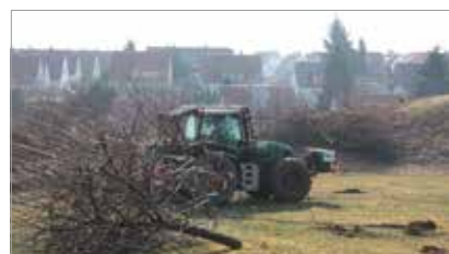
Januar 2012 Vorbereitung des Geländes
