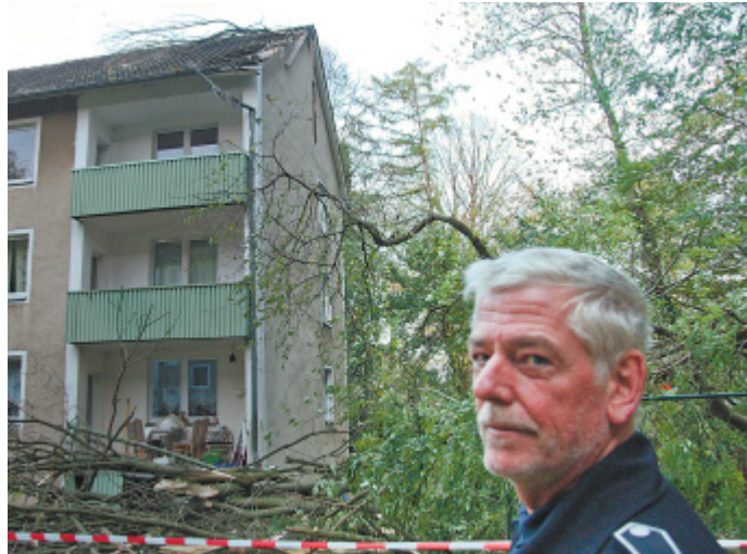
Aufs Haus: Das Dach dieses Hauses wurde schwer beschädigt. „Personenschäden gab es nicht“, sagte Wachleiter Uli Imort.
