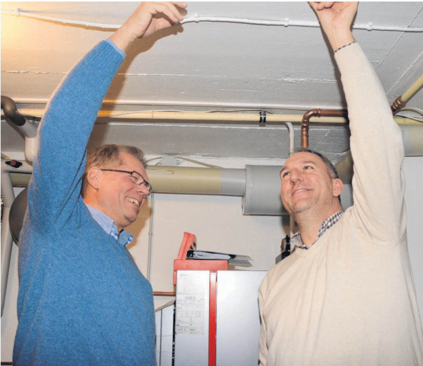
Gute Aussichten: Wenn die Kellerdecke durch Bodenplatten gedämmt wird, kann das eine Energieersparnis bedeuten und zu mehr Behaglichkeit im Kellerbereich führen. Experte Mario Lichy (r.) befühlt mit Hausherr Alfred Schwidop die Decke.
