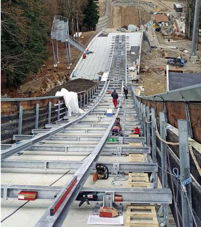
160 Tonnen Stahl wurden bei der Modernisierung der Skiflugschanze verbaut.
