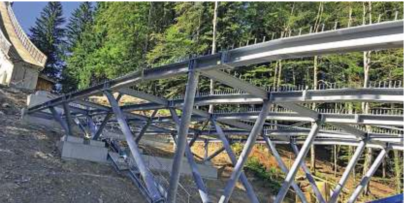
V-Stützen und geknickte Träger für den Schanzenvorbau verlangten eine präzise Fertigung. Fotos: Rädlinger
