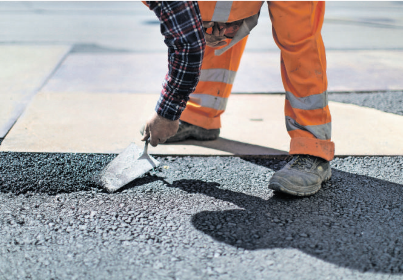
Es gibt immer etwas zu tun: Bauarbeiter beim Bodenlegen an der Zürcher Bahnhofstrasse. Foto: Gaëtan Bally (Keystone)
