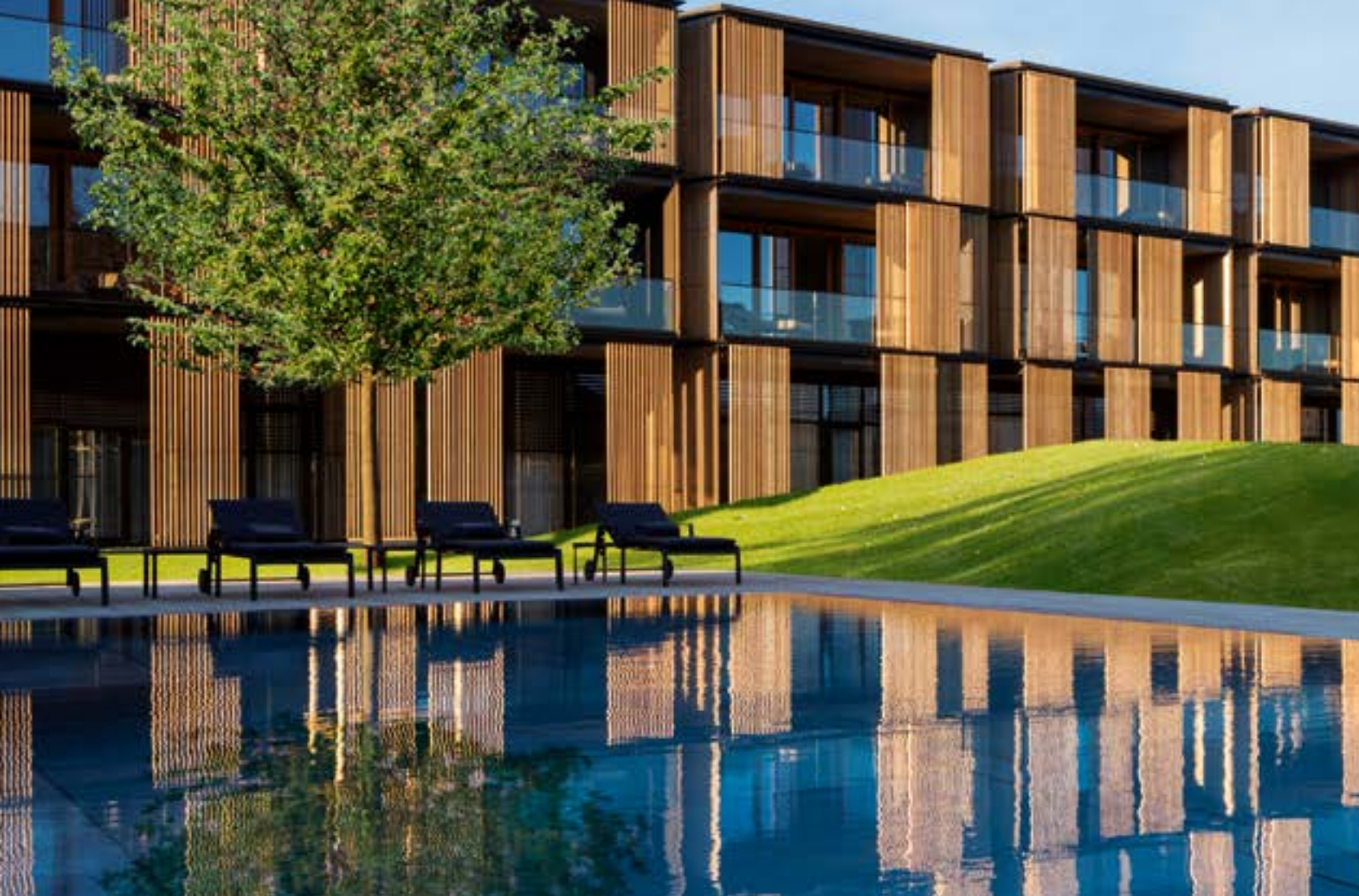
Abb. links: Glas und Sichtschutzelemente aus Lärchenholzlamellen begrenzen die Loggien, mit denen sich die beiden oberen, die Gastzimmer beherbergenden Geschosse nach außen öffnen. Die teilweise als Schiebeelemente konzipierten Lamellen wurden von einer lokalen Holzbaufirma gefertigt und montiert. Foto: HG Esch, Hennef
