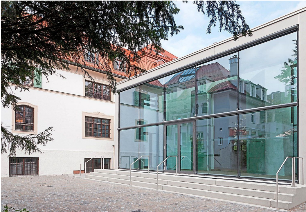
Der neue, verglaste Anbau am ehemaligen Atelier des Bildhauers Adolf von Hildebrand.
