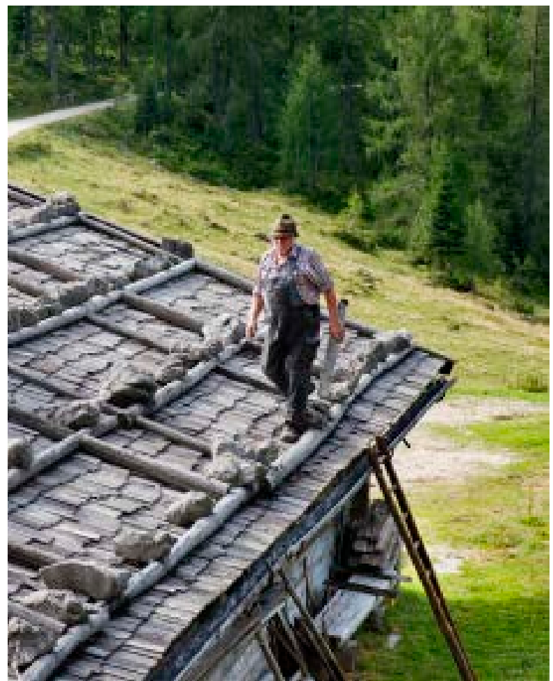
Die Schindeln aus Lärchenholz spaltet der Bauer selbst. Hier prüft er, ob er Schindeln ersetzen oder umlegen muss. Die 80 cm langen Brettchen kann er vier Mal wenden, dann braucht er neue. Paul Zimmermann saß schon als kleiner Junge an diesem Platz im Kaserstöckl. Damals war seine Oma Kathi die Sennerin auf der Alm.
