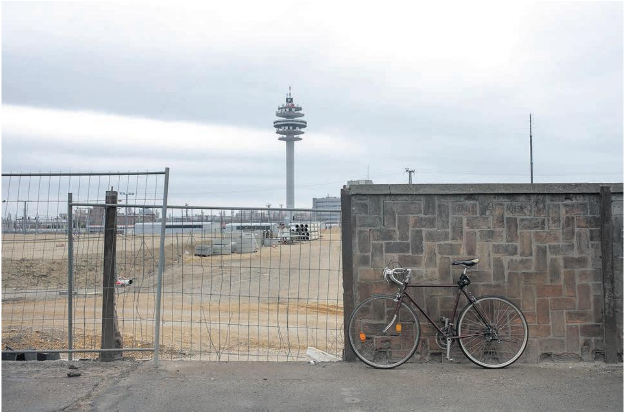
Alles Baustelle. Im Moment ändert sich viel in Favoriten.
