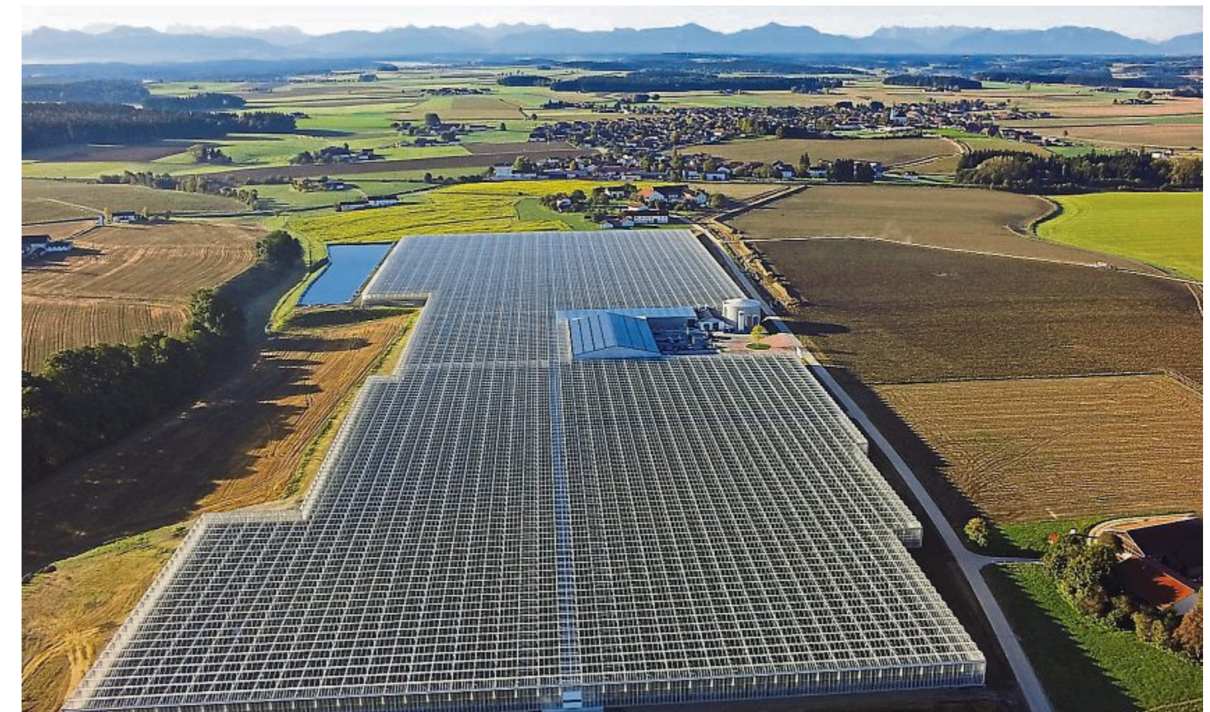
Auf dem Gelände wäre Platz für zweimal die Allianz Arena gewesen. In den riesigen Gewächshäusern reifen nun Tomaten und Paprika.
