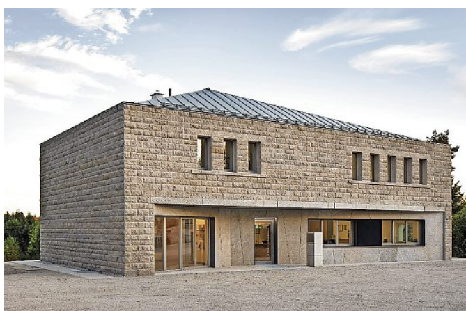
DAS 2016 ERBAUTE BÜRO- UND AUSSTELLUNGSGEBÄUDE DES FLOSSENBÜRGER GRANITWERKS HELGERT ZEIGT DIE MÖGLICHKEITEN DER GESTALTUNG MODERNER GEBÄUDE MIT GRANIT. FOTO: GRANITWERK HELGERT
