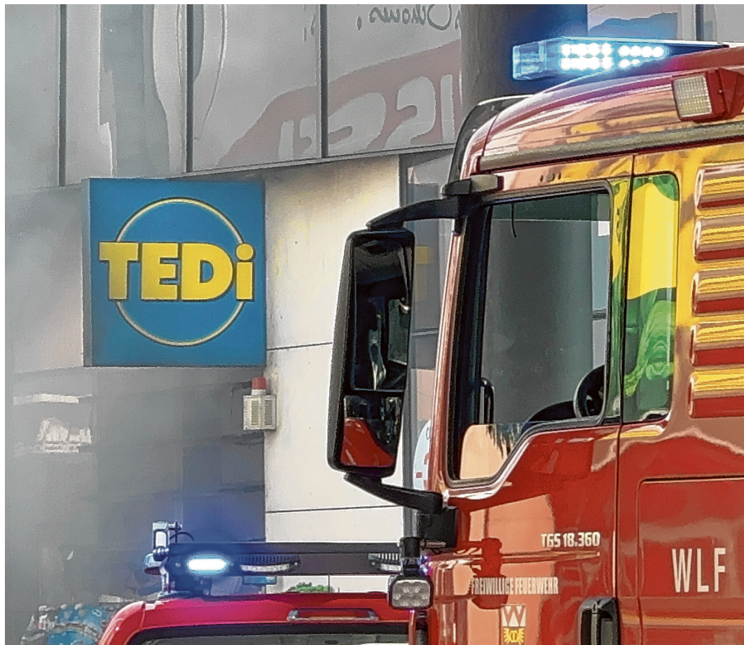
Ein Geschäft im Wörgler „Plus“-Einkaufszentrum ging am Montag in Flammen auf. Laut ersten Einschätzungen entstand dadurch ein Schaden von mehr als 100.000 Euro. Foto: zoom.tirol
